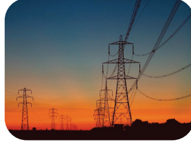
Yaz aylarında elektrik tellerinin sarkması
